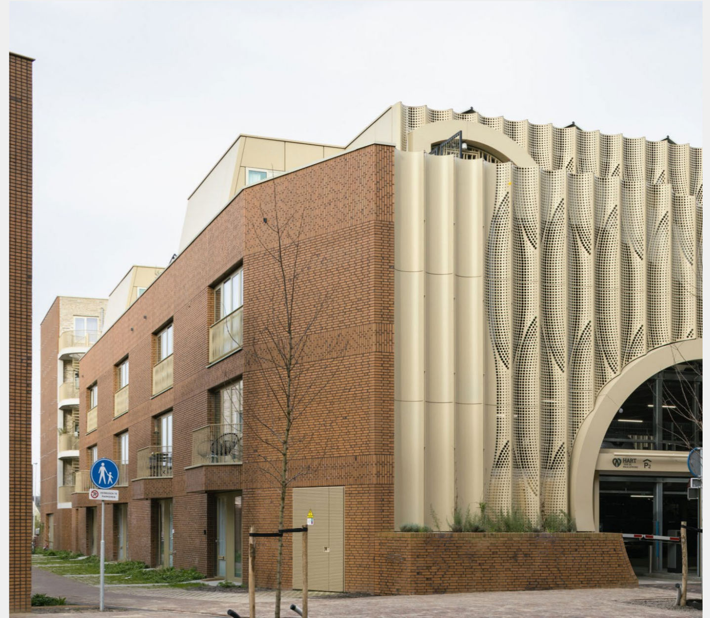
Stadswoningen met rug tegen parkeergarage (Waalsprong, Nijmegen)
