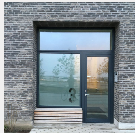
Entrees naar boven liggende appartementen
