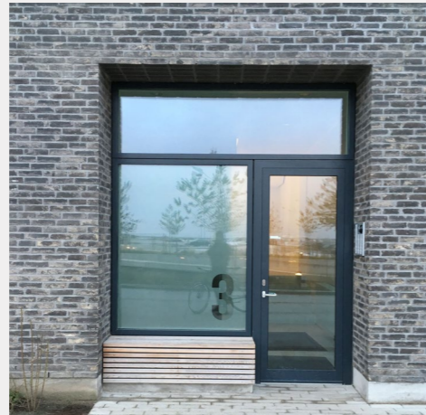
Entrees naar boven liggende appartementen
