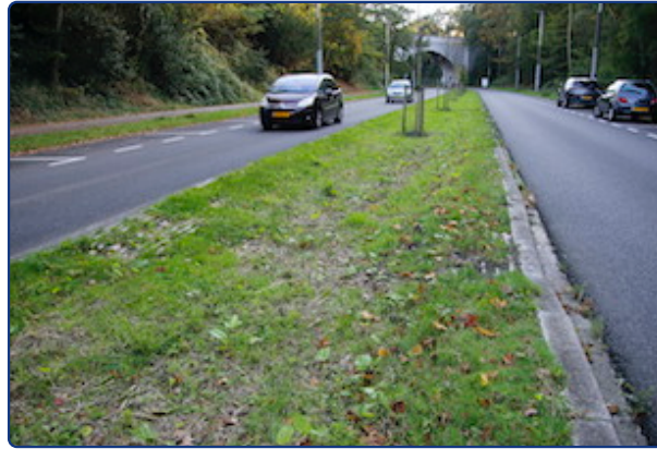
Infiltratie in berm Cattepoelseweg.
