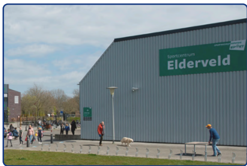
Lange blinde gevel van het Sportcentrum Elderveld
