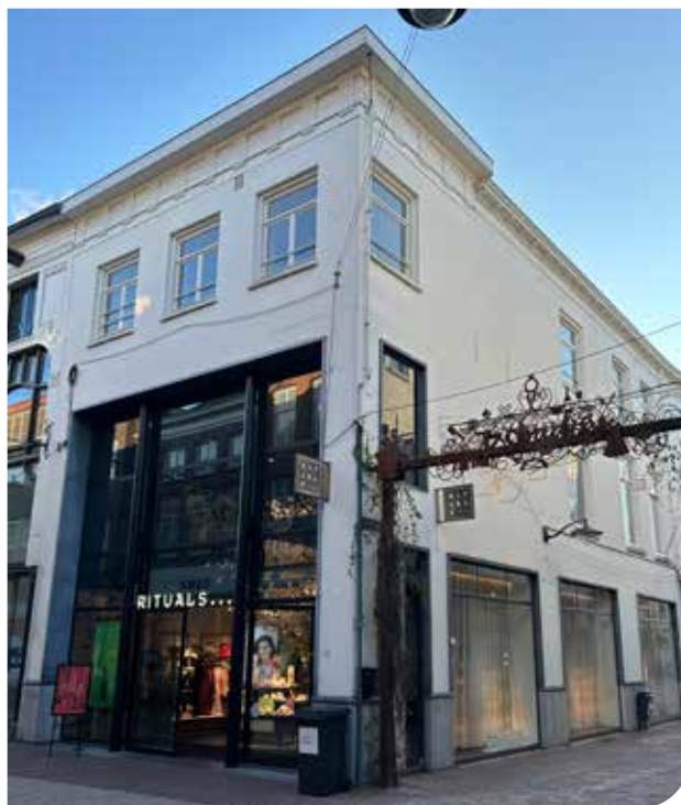
OP DE BOVENVERDIEPING VAN HET HUIS OP DE HOEK VAN DE KETELSTRAAT EN DE ZWANENSTRAAT HIELD STOLK ZIJN REDEVOERING. FOTO ASCHWIN DROST.
